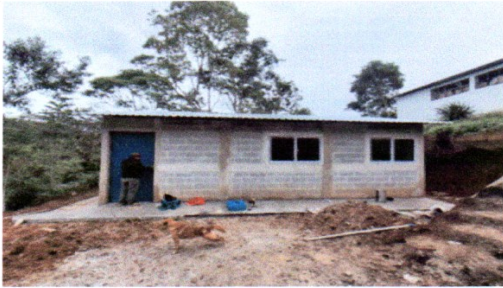
Foto1: MEJORAMIENTO DE AULA TIPO PÓRTICO FINALIZADO 100%
