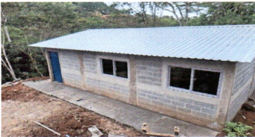
Foto 5: MEJORAMIENTO DE PUERTA FINALIZADO AL 100%
